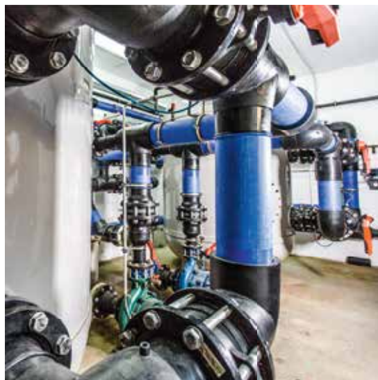
Газовое оборудование для огненных эффектов американской горки Водан и установка водоподготовки с фильтровальной станцией для американской горки Атлантика СуперСплэш.
